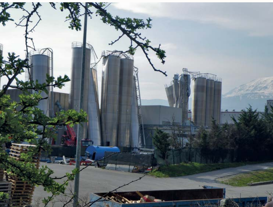
Vue de l'endommagement par flambage de silos à Bazzano, suite au séisme de l'Aquila du 6 avril 2009 (Italie, 2009). © BRGM - Samuel Auclair
