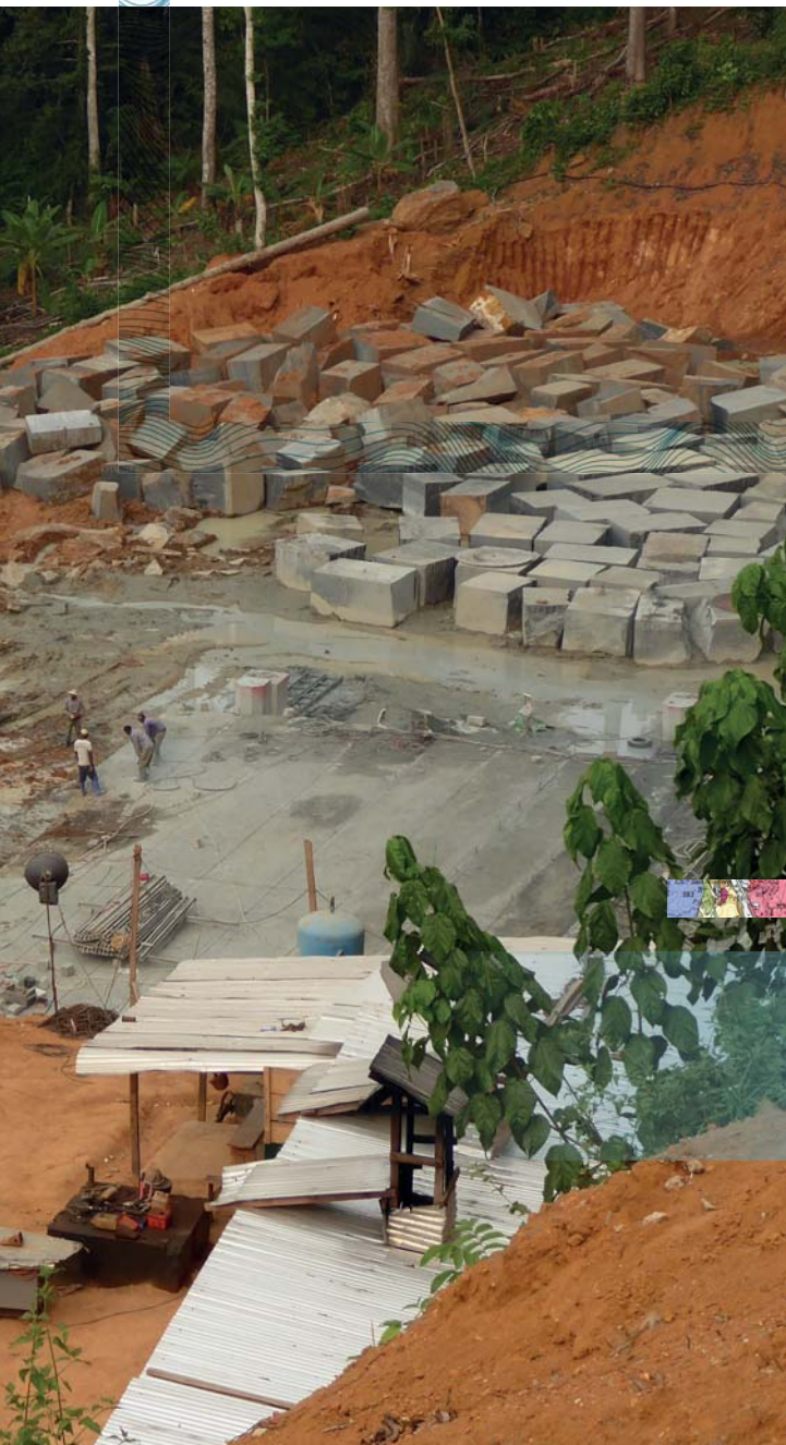
Carrière de blocs pyroxénite (Afrique centrale, 2021). © Thomas Gutierrez
