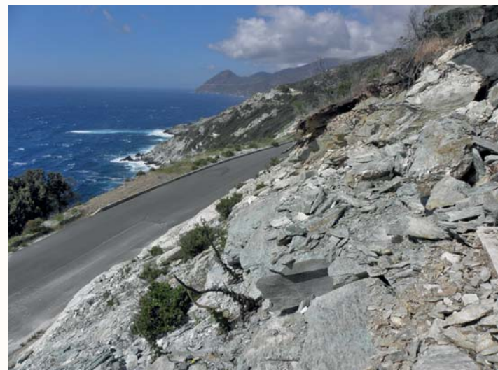
Affleurement de métagabbros à smaragdite recoupés par des veines à trémolite-amiante (Haute-Corse, 2013). © BRGM – Didier Lahondère
