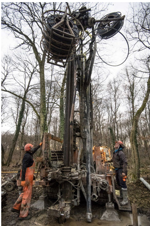
Forage de sonde géothermique © BRGM
