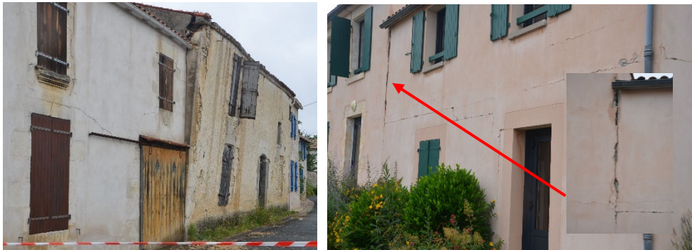
Figure 8 : Ces deux photos (©BRGM-JC Audru, photos 4485 -4467 -4468) illustrent les dommages observés sur la commune de La Laigne, à savoir des dommages dus à la discontinuité sur les caractéristiques structurales et/ou à l'interaction entre bâtiments.
