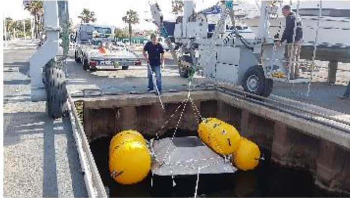
Figure 3 Mise à l'eau de la cage anti-chalut
