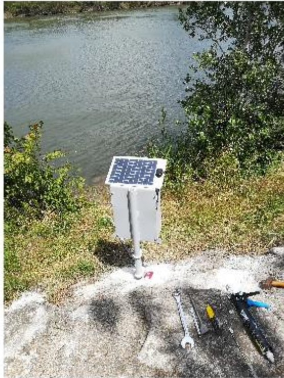
Figure 7 Coffret temps réel
