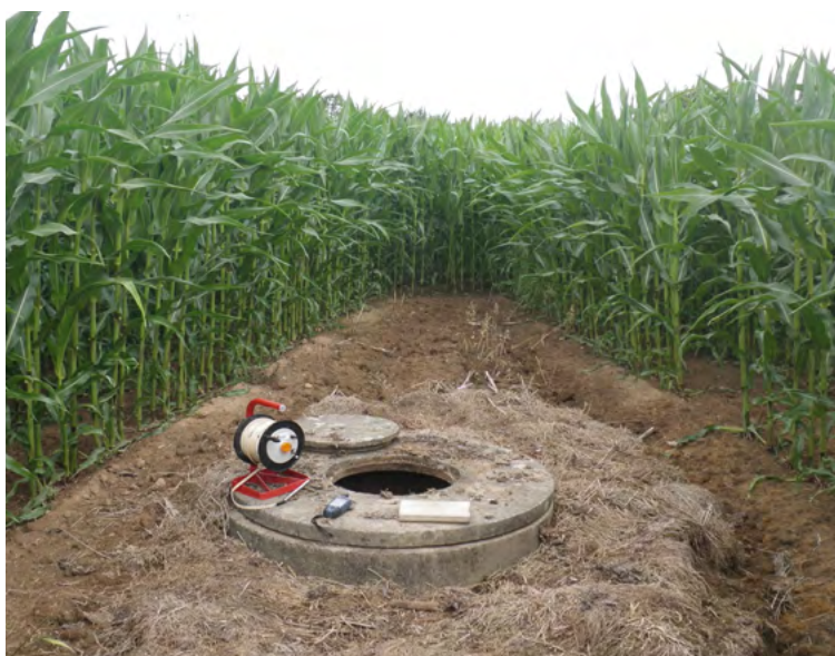
Sonde piézométrique : la partie métallique est plongée dans le puits et sonne au contact de l'eau souterraine.
