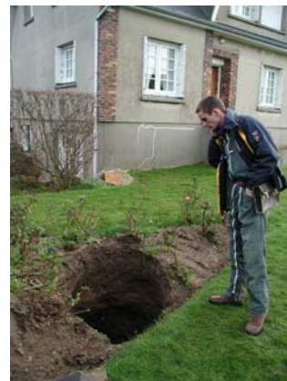
Effondrement d'un puits de marnière
